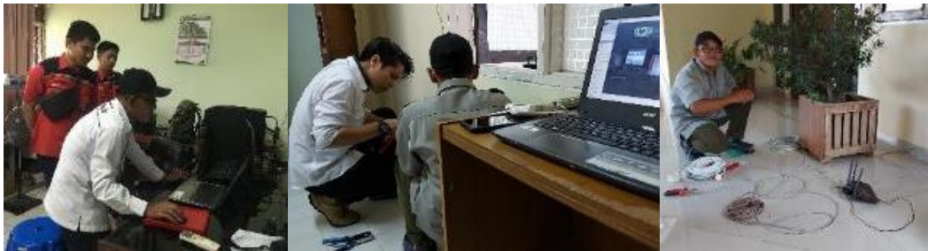
Gambar 29. Konfigurasi ulang jaringan Astinet, setting ulang account yang terkoneksi ke jaringan LAN dan WIFI, memperbaiki jaringan Access Point ke Auditorium dan mengganti switch hub di ruangan pelayanan teknis
