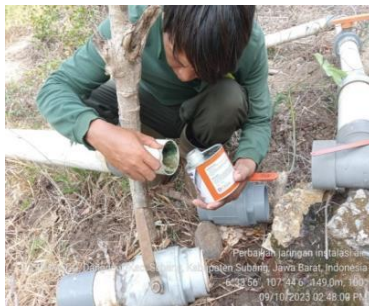
Gambar 7. Perbaikan pipa jaringan air yang pecah (kiri), Penggemburan media olah tanam pada tanaman durian yang masih kecil (kanan)
